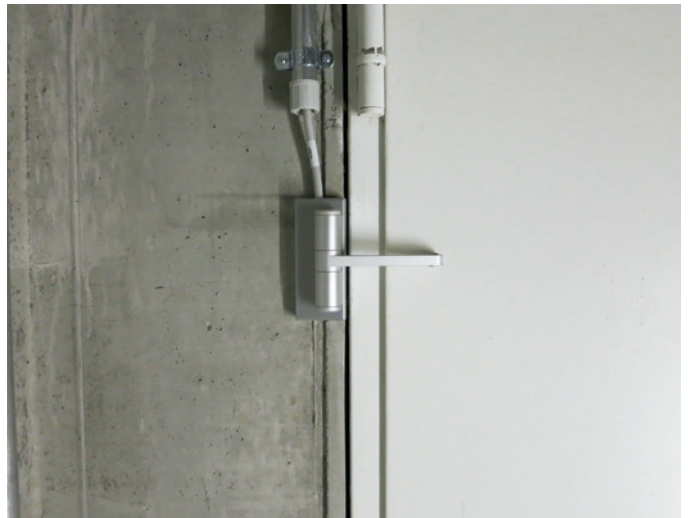
Abb. 4: Drehwinkelgeber an der Tür
