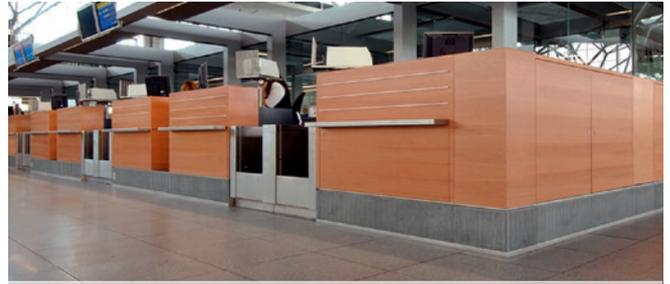
Der aus LSE Material hergestellte Sockelquellluftdurchlass ist mit langen aktiven Elementen und kurzen Blindelementen in den Check-In-Schalter integriert, Flughafen Stuttgart, Terminal 3.
