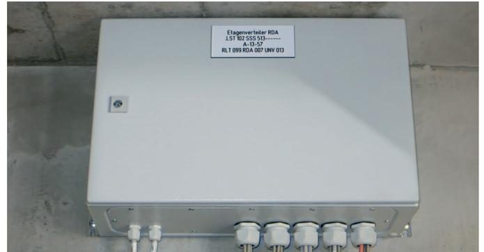
Abb. 6: Etagenverteiler
