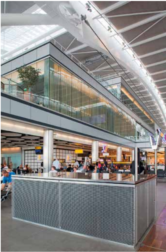
Flughafen Heathrow, London, Terminal T5A
