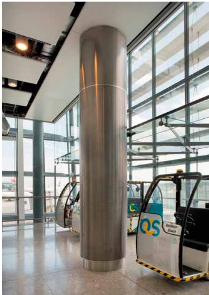
Flughafen Heathrow, London, Terminal T5A
