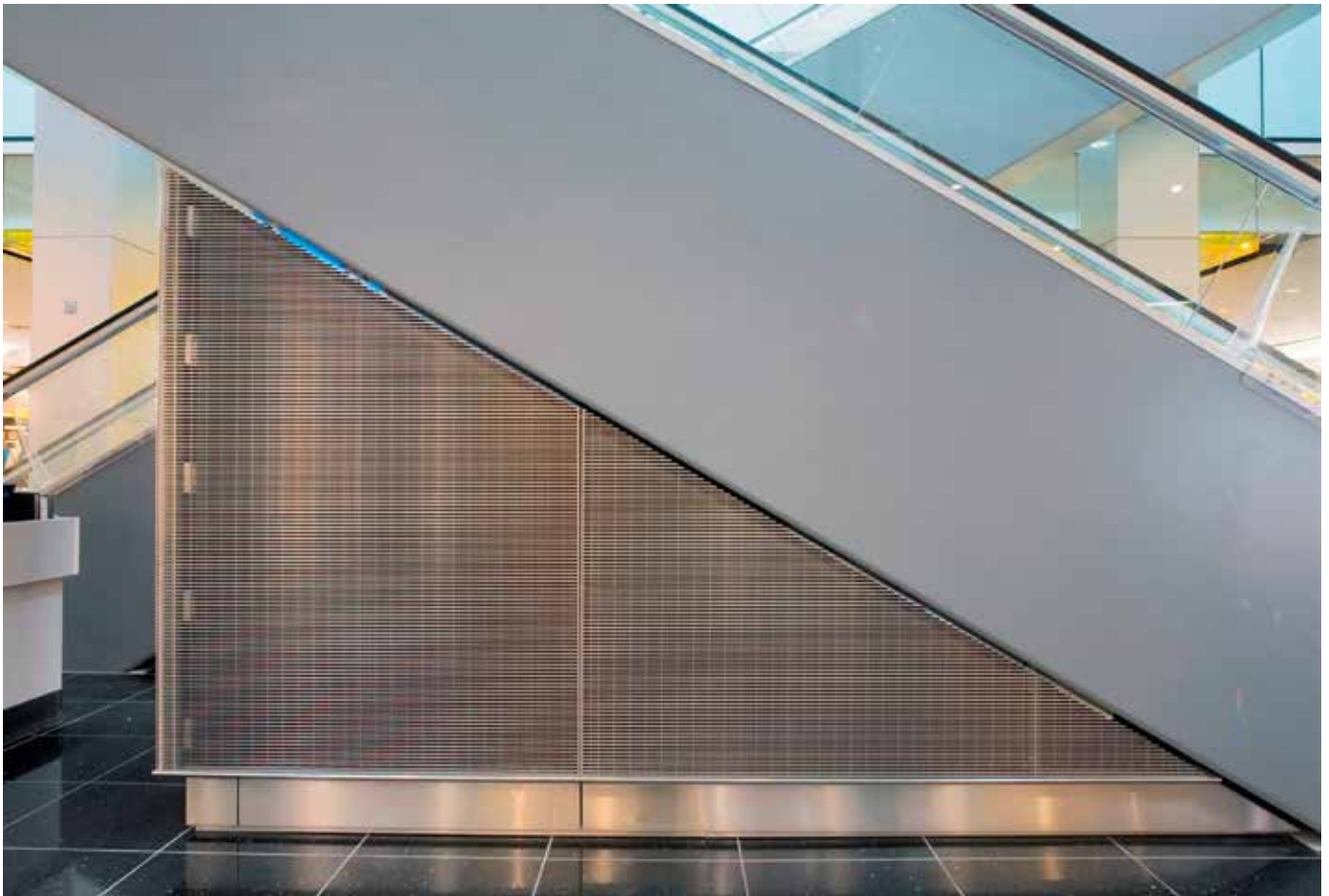
Flughafen Heathrow, London, Terminal T5A
