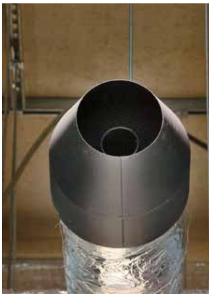
Flughafen Heathrow, London, Terminal 5 TTS Bereich
