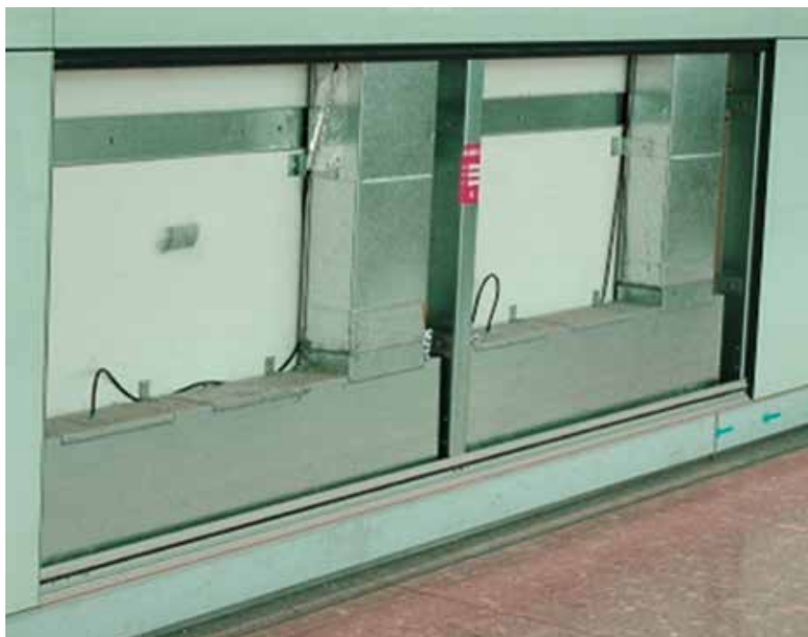
Flughafen Heathrow, London, Terminal T5A
