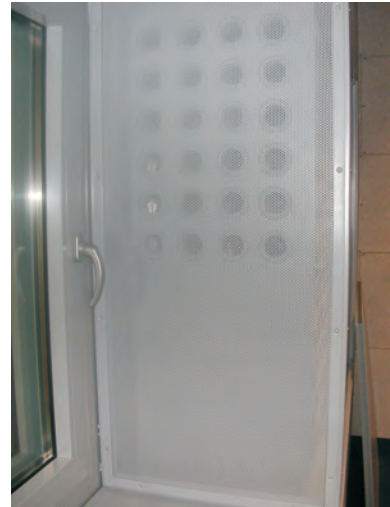
Abb. 5 Aktive Fensterfaschen gleichen den Flächenverlust aus
