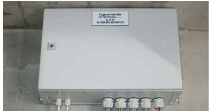
Abb. 6: Etagenverteiler
