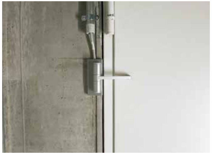
Abb. 4: Drehwinkelgeber an der Tür
